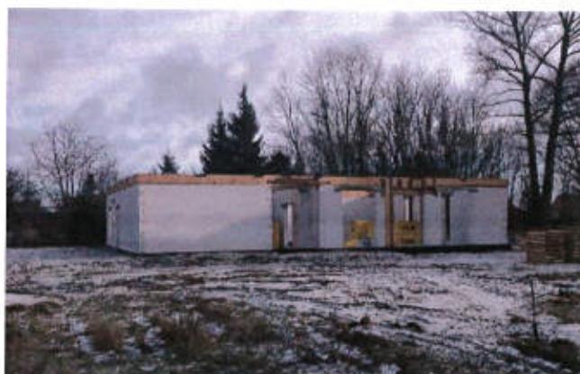
Budowa świetlicy wiejskiej w Chlebowie wraz z zagospodarowaniem terenu
